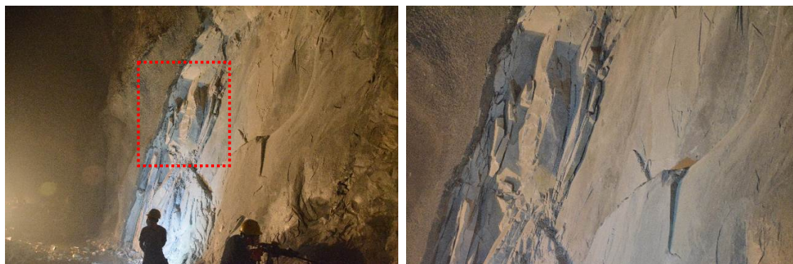
(c) 7#实验室 K0+062 南侧边墙（下层开挖，右图为左图虚线框的局部放大图）
