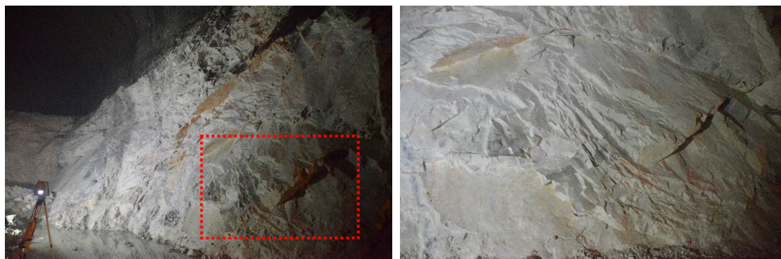
(d) 7#实验室 K0+058 北侧底角（下层开挖，右图为左图虚线框的局部放大图）
